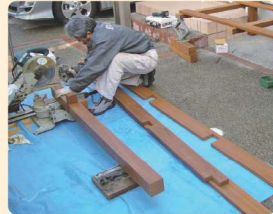
施工や下処理を行う際は、木くずが散ららないようにビニールシートの上で行ってください。
