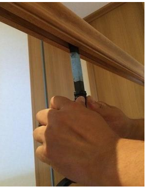
※子柱の取り付け
