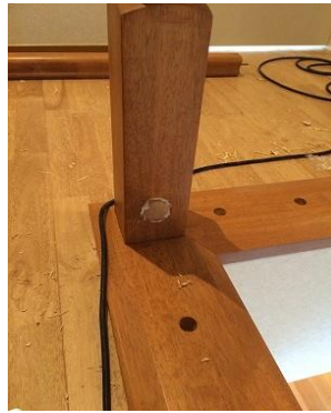
※親柱の取り付け
