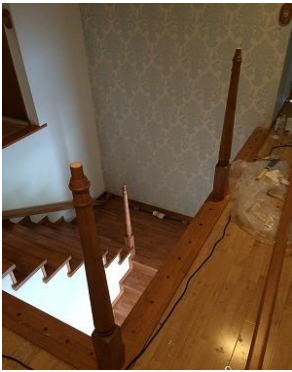
※親柱の取り付け
