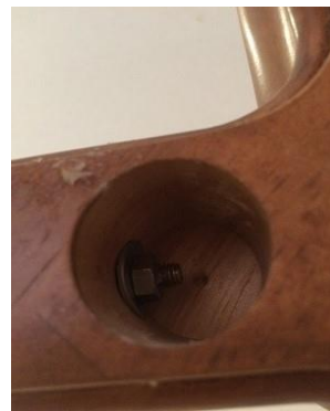
※木製手摺取り付け
