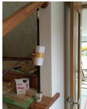
※子柱の取り付け
