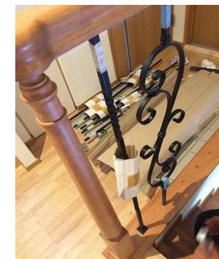
※子柱の取り付け
