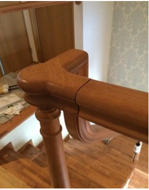
※木製手摺取り付け
