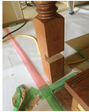
※親柱の取り付け
