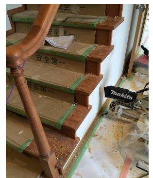
※木製手摺取り付け
