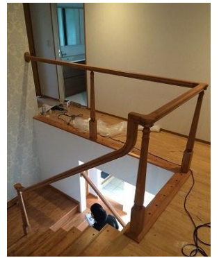
※木製手摺取り付け
