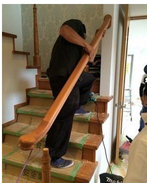
※木製手摺取り付け
