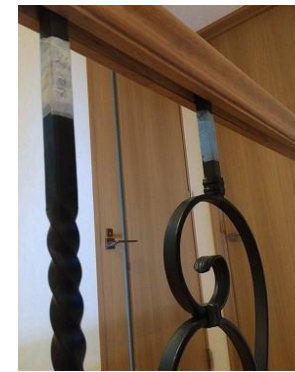
※子柱の取り付け
