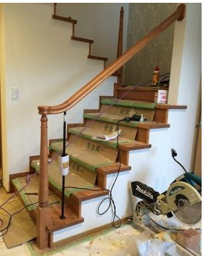
※子柱の取り付け
