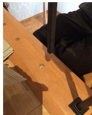
※子柱の取り付け
