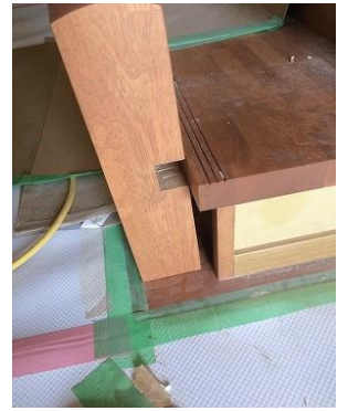
※親柱の取り付け
