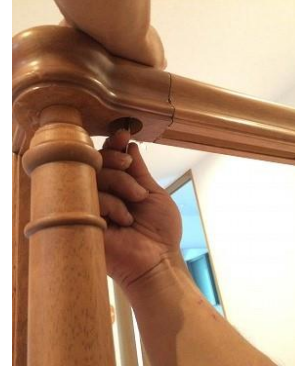
※木製手摺取り付け
