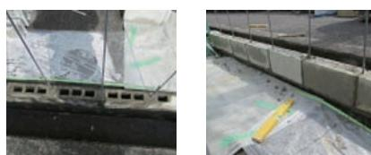
④ガラスブロックを積み上げていきます(本施工写真は立骨を使用しています)。
