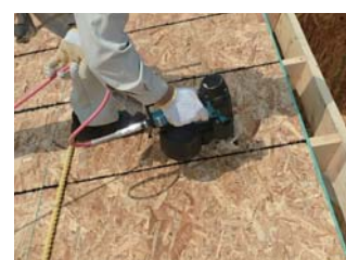
12mmネイルライン有OSB 屋根の上での墨出しが不要
